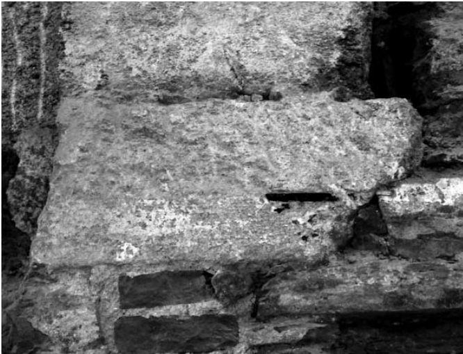
Fig. 9. Saimel esquerdo, no que se aprecia que picaron o seu voado. Resultan visíbeis os vestixios de enfuscado branco así como os restos de lucido negro. Debaixo un dos varios machinais localizados nesta parede. Poden verse tamén, ao remate dos perpiaños, as pegadas de extracción das pezas do arco.
