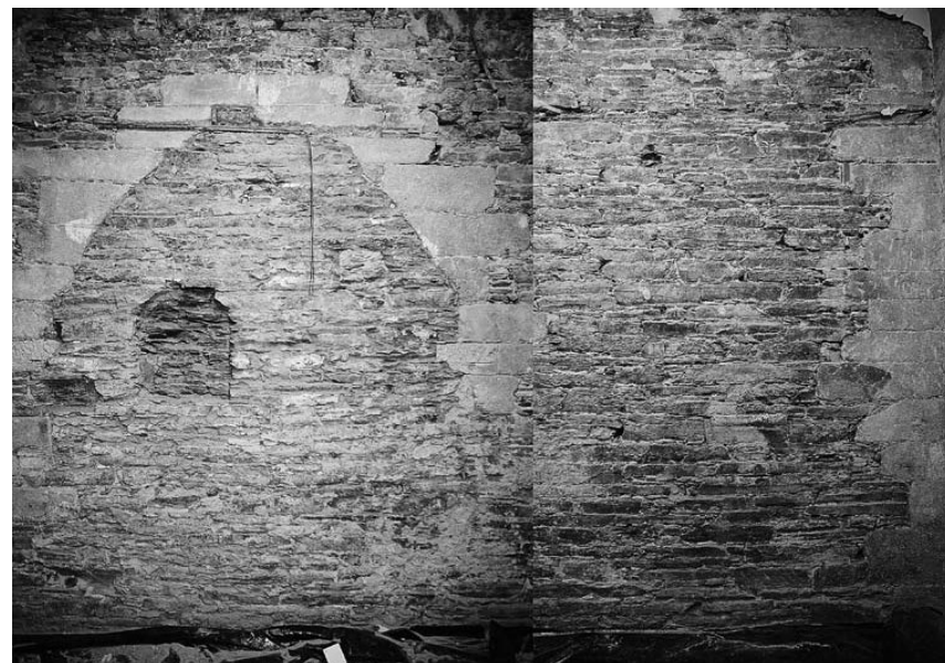
Fig. 8. A esquina NE do claustro, cos elementos construtivos descubertos: a fiada apegada ao contraforte á esquerda e o enmarque/arco á dereita, embutidos nun mesmo lenzo. Obsérvanse as evidentes diferenzas morfolóxicas das pezas e de morteiros entre este pano e o recheo interior do arco.
